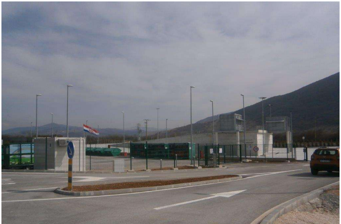
Slika 6: Izgrađeno Reciklažno dvorište Gračac uz novoizgrađenu Pretovarnu stanicu Gračac u sastavu Centra za gospodarenje otpadom Zadarske županije „Biljane Donje“
