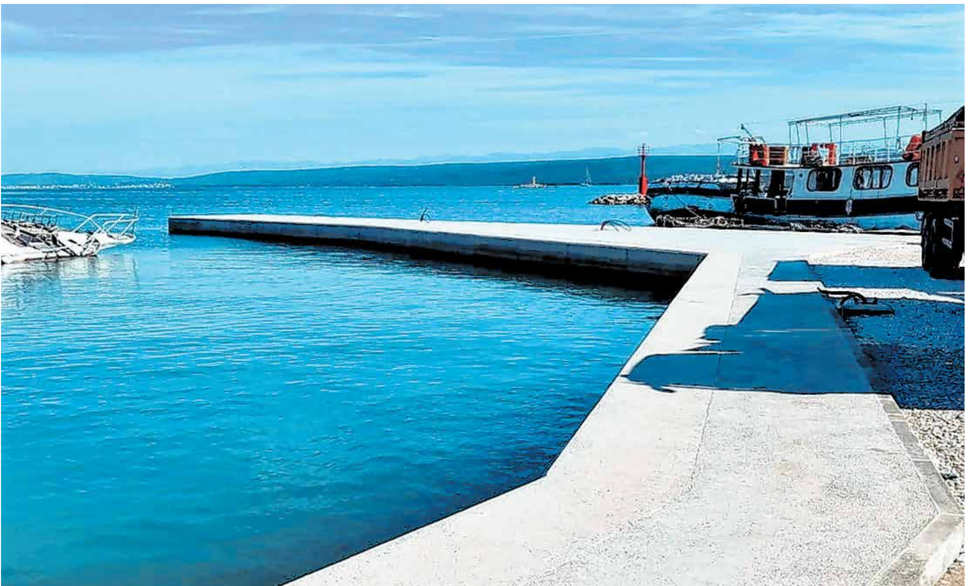
Županijska lučka uprava Zadar dovršila je projekt sanacije luke Mrljane
