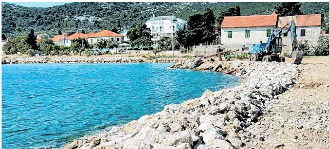
Sanacija zaštitnog kamenometa
