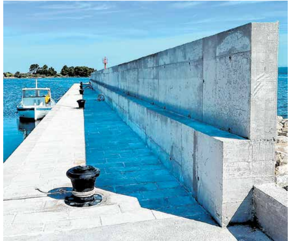
Sanirana su oštećenja dijelova obalne konstrukcije
