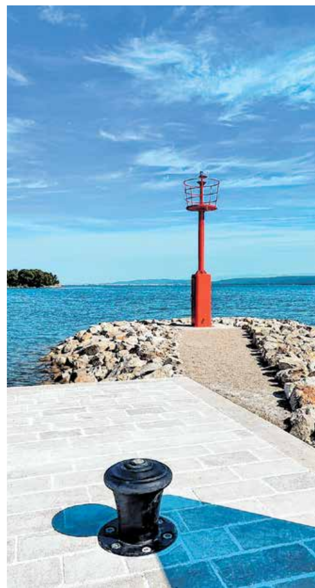
Projekt sanacije luke Mrljane proveden je u dvije faze
