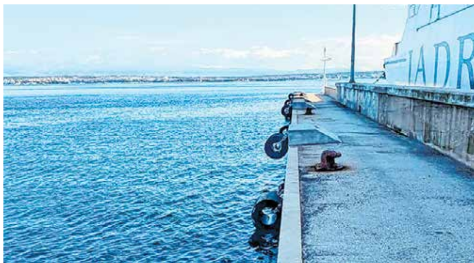
Novim bokobranima povećana sigurnost prilikom pristajanja trajekta »Ugljan« u luci Preko
