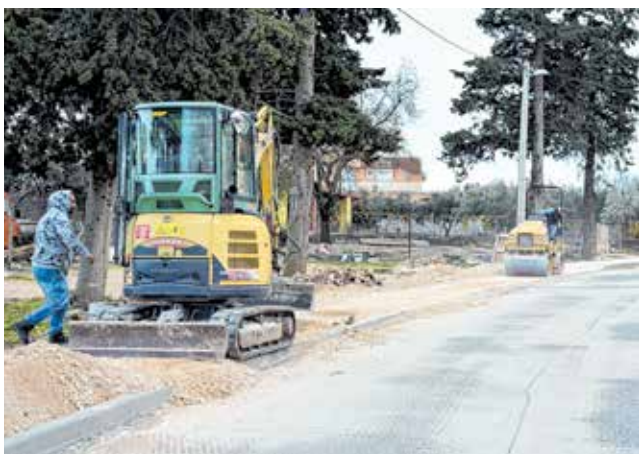
Asfaltiranje ceste i izgradnja nogostupa u Sikovu u punom jeku
