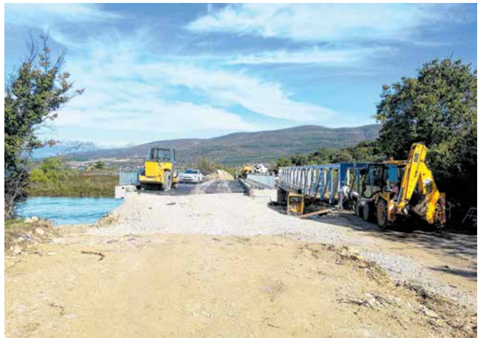
Uskoro svečano otvorenje novog mosta preko Karišnice
