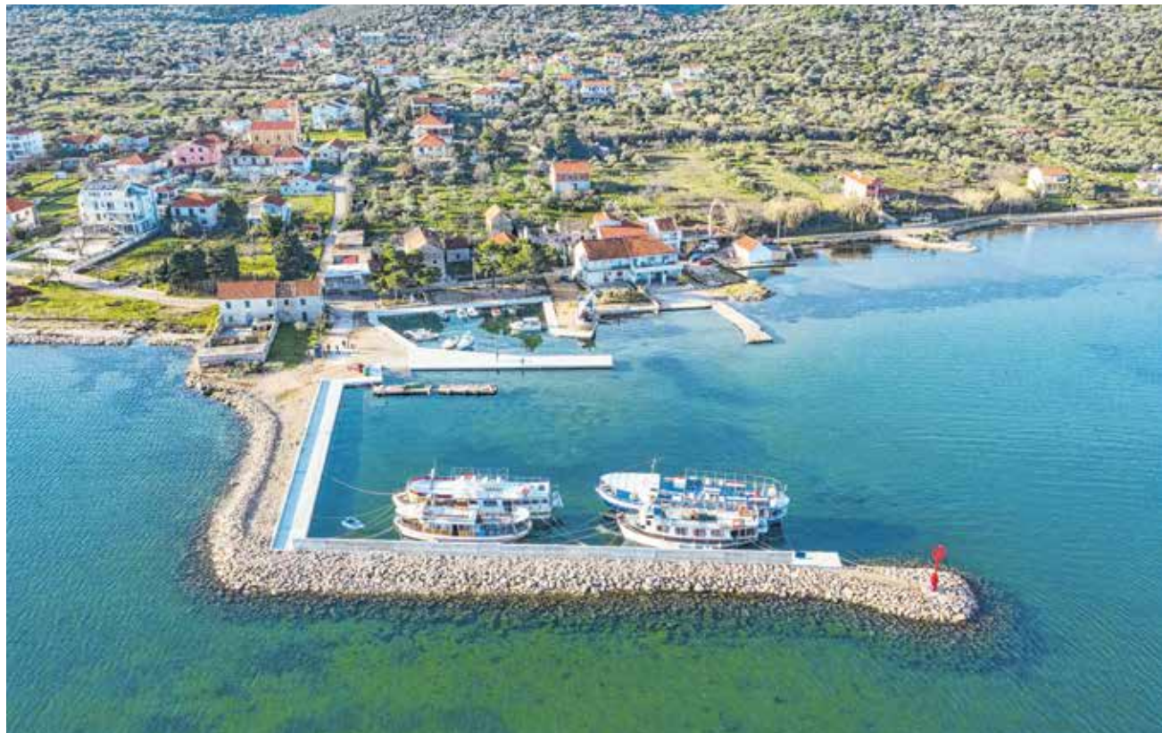
Završeni radovi na sanaciji obale i lukobrana u luci Mrljane
