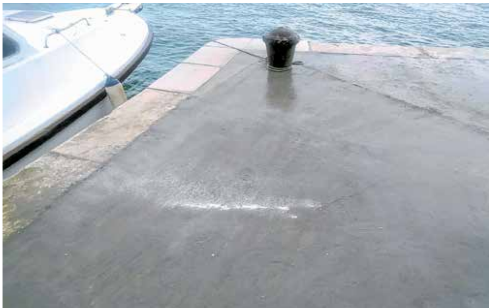
Nova podloga na obnovljenom gatu
