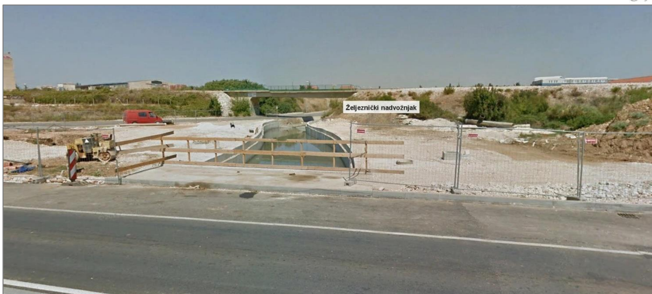
Slika 2.10 Most na Gaženičkoj cesti – pogled uzvodno prema željezničkom nadvožnjaku (Izvor: Google Earth)
