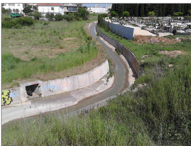
Slika 2.13 Pogled uzvodno s mosta na Biogradskoj ulici (Izvor: Idejni projekt)
