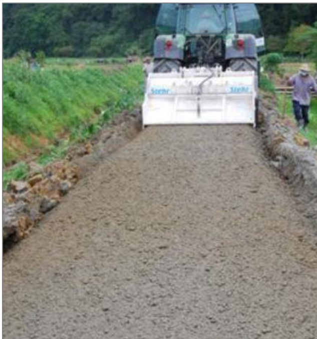
Slika 2.36 Miješanje tla s cementom i aditivom (Izvor: Idejni projekt)
