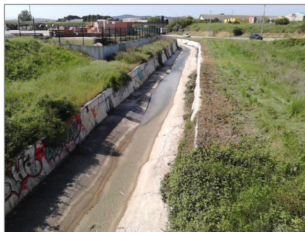
Slika 2.11 Pogled nizvodno s mosta na Biogradskoj ulici (Izvor: Idejni projekt)
