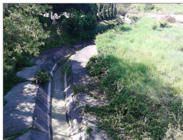
Slika 2.14 Pogled nizvodno s mosta na ulici F. Lisice (Izvor: Idejni projekt)
