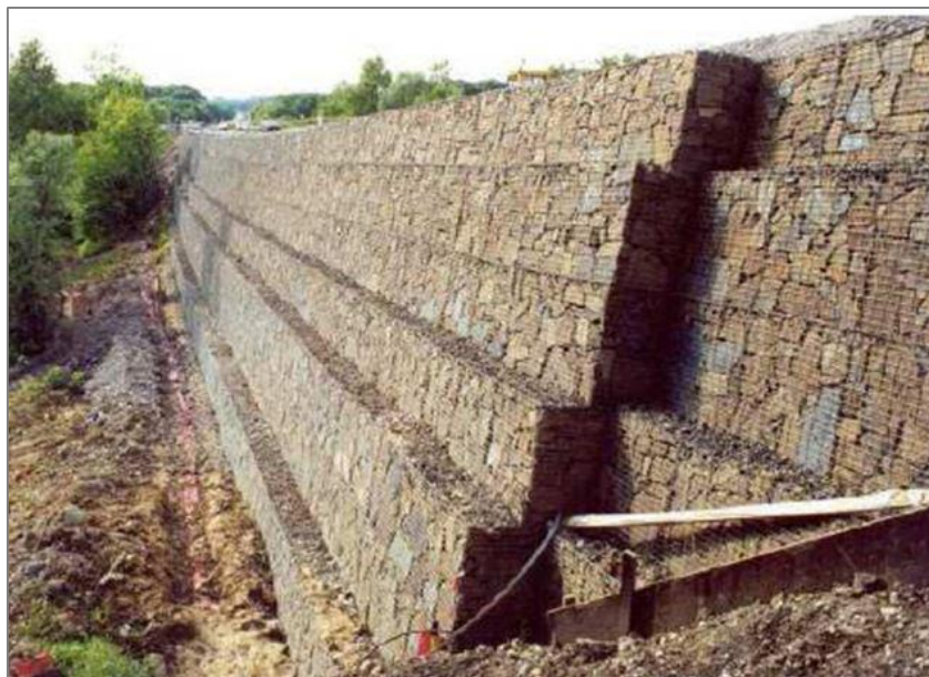
Slika 2.37 Gabionski zid (Izvor: Matešić, 2012/2013)
