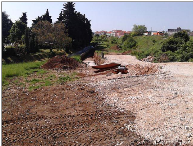
Slika 2.15 Upuštanje kišnog preljeva UPOV-a grada Zadra u vodotok Ričine nizvodno od mosta na ulici F. Lisice (Izvor: Idejni projekt)
