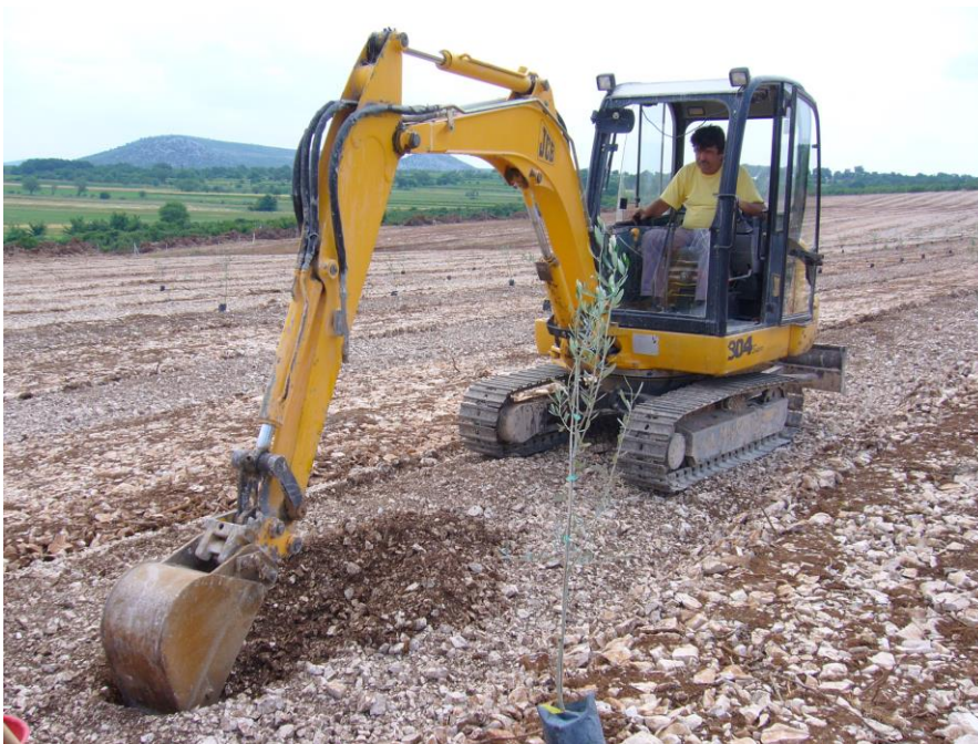
Slika 4 Kopanje sadnih jama neposredno pred sadnju malim bagerom
