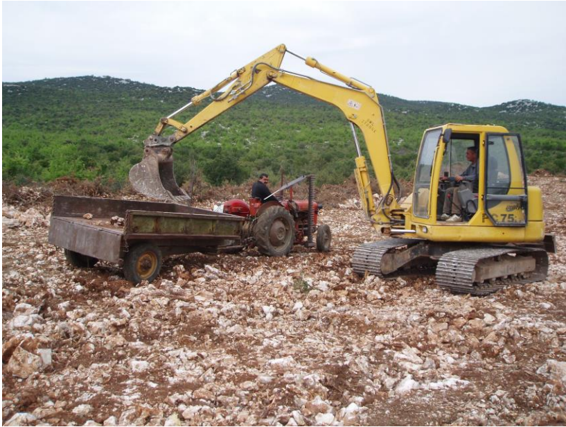
Slika 2 Utovar i odvoz krupnog kamena
