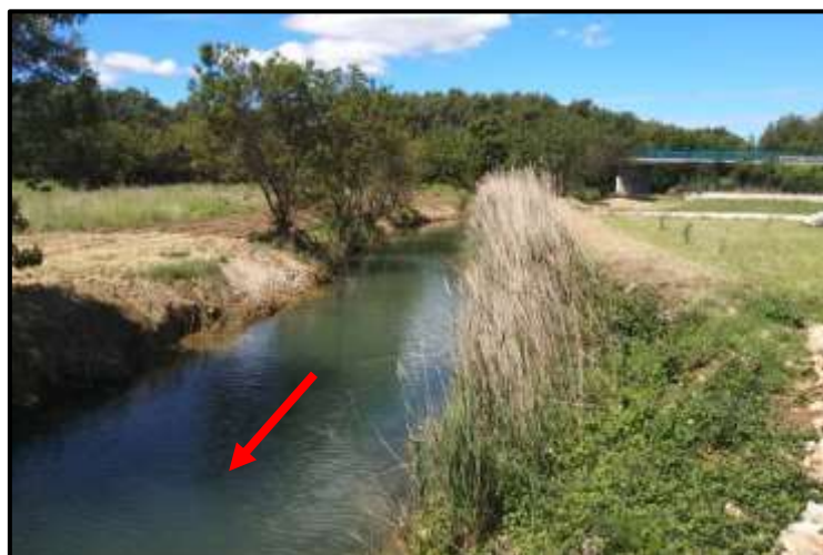
Slika 2.1-3. Izgled profila korita vodotoka Bašćica, pogled od stac. km 0+735 uzvodno prema mostu na D8, s označenim smjerom tečenja (izvor: GRAD INVEST d.o.o., 2019.)
