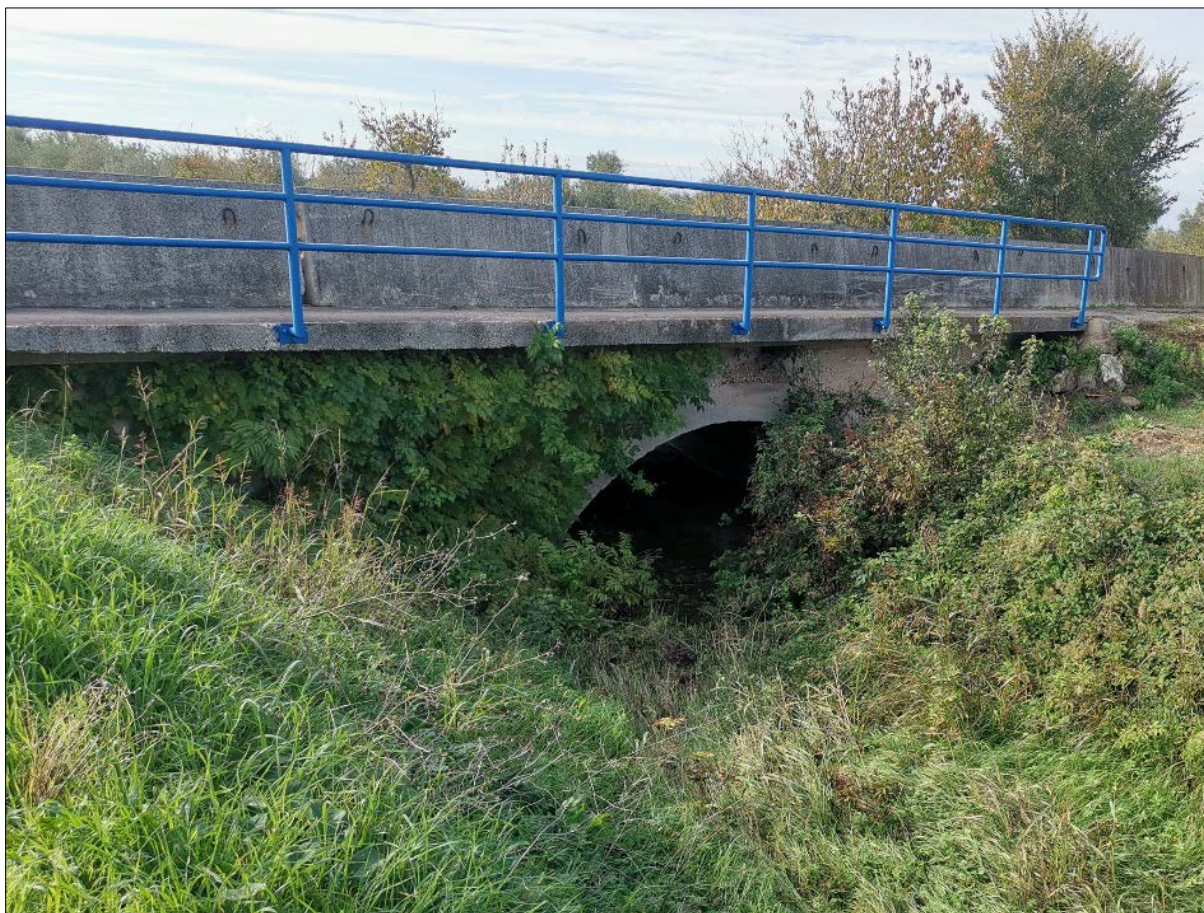
Slika 8. Postojeći cestovni propust (Izvor: Idejni projekt, HIDRO-EXPERT d.o.o., Rijeka, travanj 2022.)
