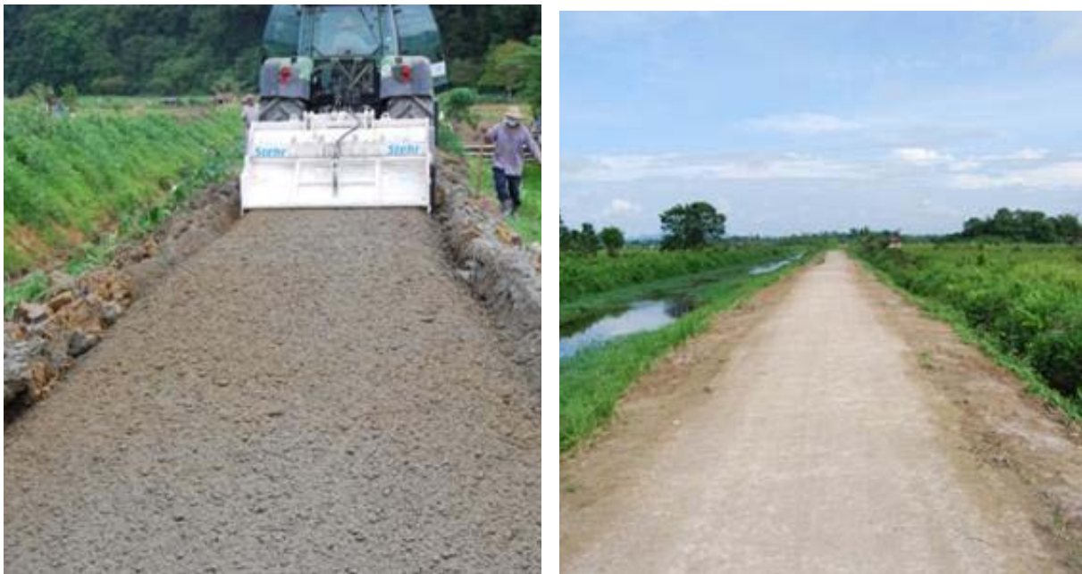
Slika 10. Primjer izvedbe i završnog izgleda ceste izvedene hladnom reciklažom (Izvor: Idejni projekt, HIDRO-EXPERT d.o.o., Rijeka, travanj 2022.)
