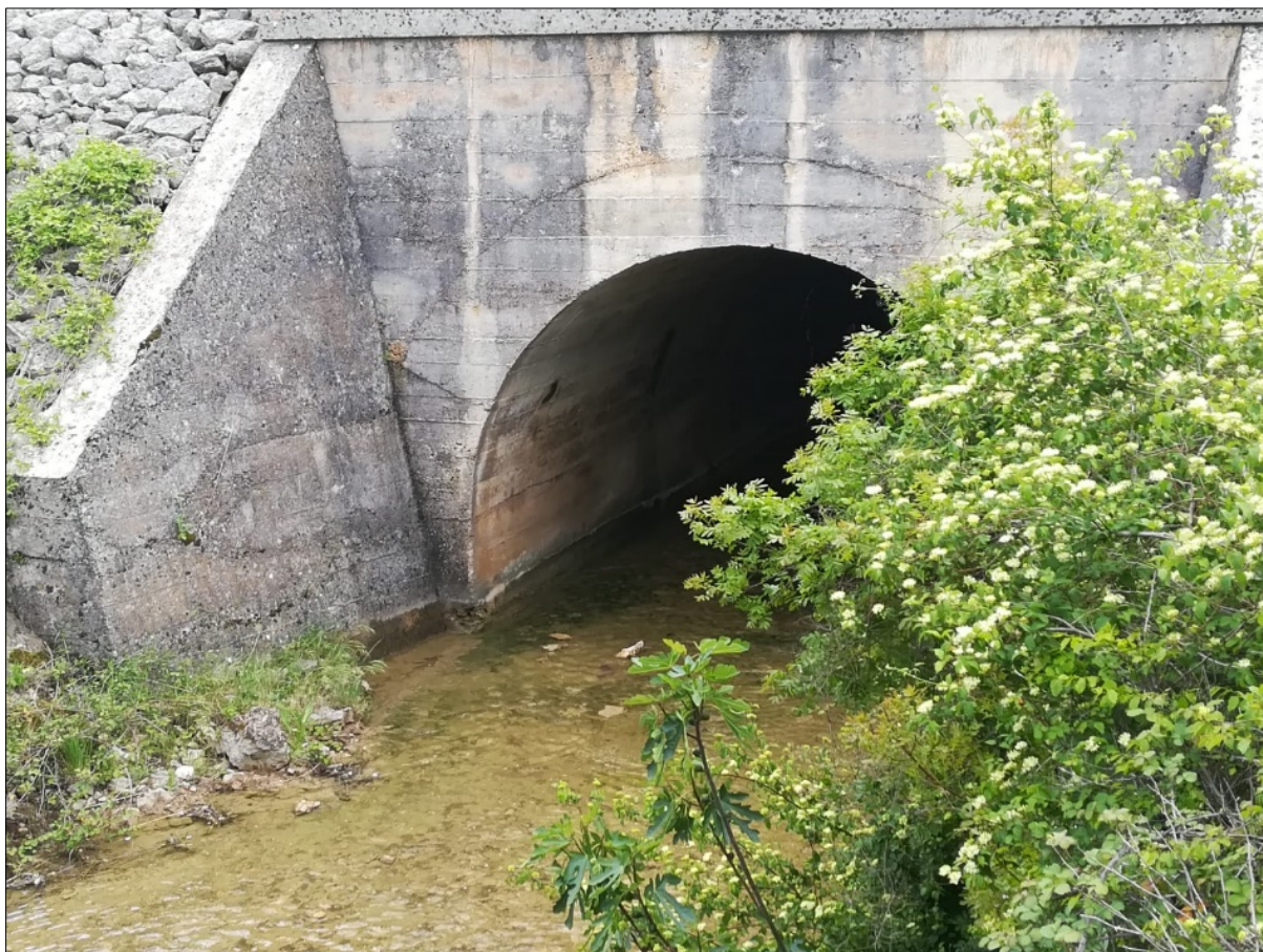
Slika 7. Propust ispod željezničke pruge (Izvor: Idejni projekt, HIDRO-EXPERT d.o.o., Rijeka, travanj 2022.)
