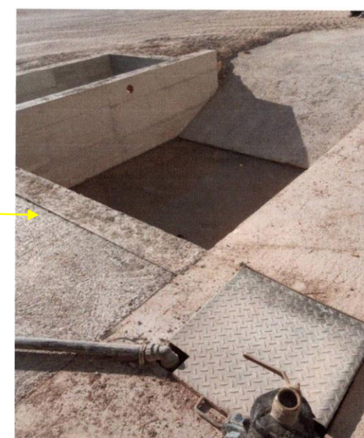
Gustirna za prihvrat pročišćene industrijske otpadne vode i vode iz vodovoda i zdenca
