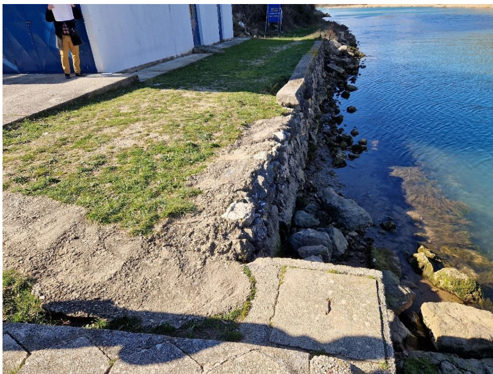
sl. 1.4.3: Pogled na vertikalni zid i kraj uređene šetnice
