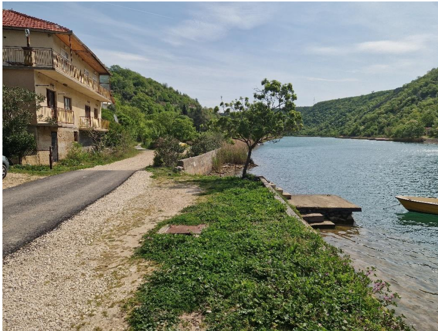
sl. 1.4.22: Završetak uređene obaloutvrde sa šetnicom te vertikalnim zidom
