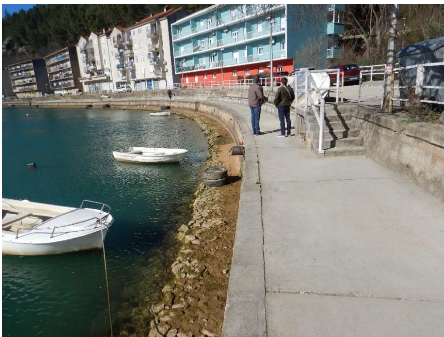
sl. 1.4.11: Uređena obaloutvrda sa šetnicom i vertikalnim obrambenim zidom te pristupnim stubište
