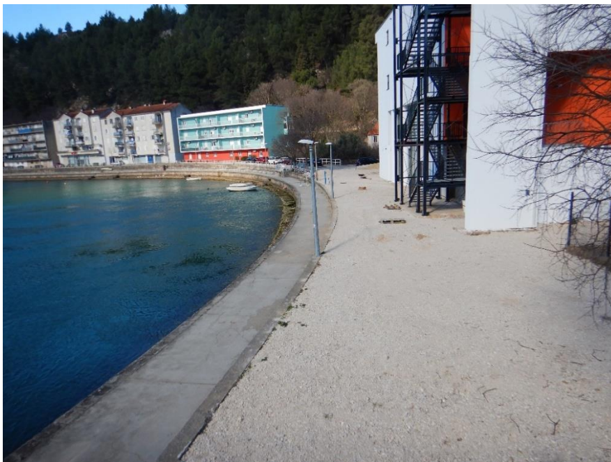
sl. 1.4.10: Pogled uzvodno s mosta prema predmetnoj dionici
