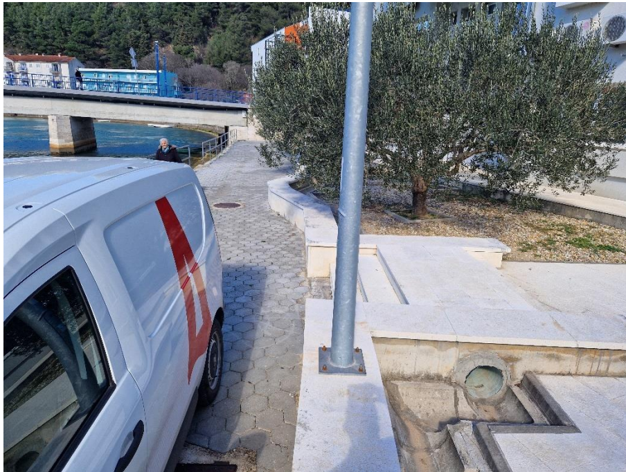
sl. 1.4.15: Pogled na obrambeni zidić i sustav oborinske odvodnje
