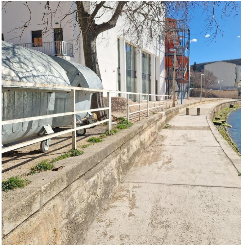
sl. 1.4.12: Uređena obaloutvrda sa šetnicom i vertikalnim obrambenim zidom
