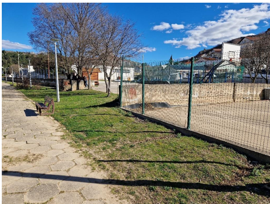
sl. 1.4.7: Pogled prema dijelu gdje nije izvedena zaštita vodim građevinama
