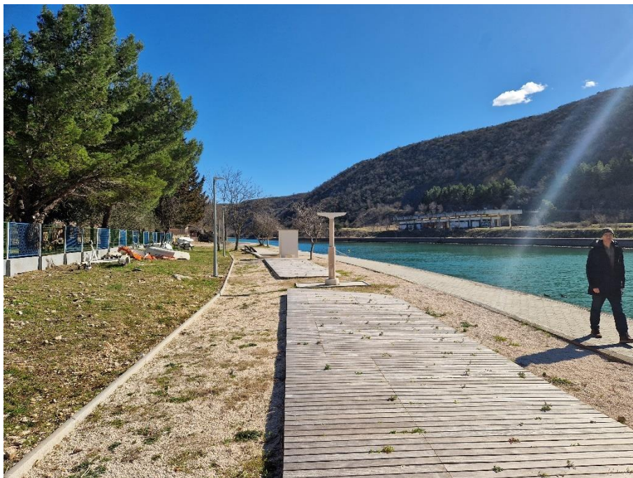
sl. 1.4.19: Pogled uzvodno na kupalište i šetnicu te ogradni zid vrtića
