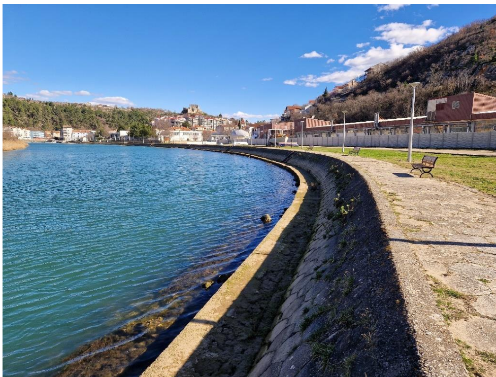
sl. 1.4.4: Pogled uzvodno na uređenu obaloutvrdu i šetnicu
