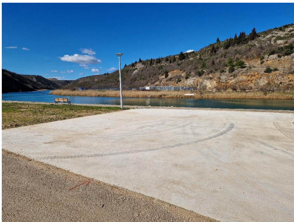
sl. 1.4.5: Betonska podloga u privatnom vlasništvu neposredno uz samu šetnicu na kraju opisane dionice
