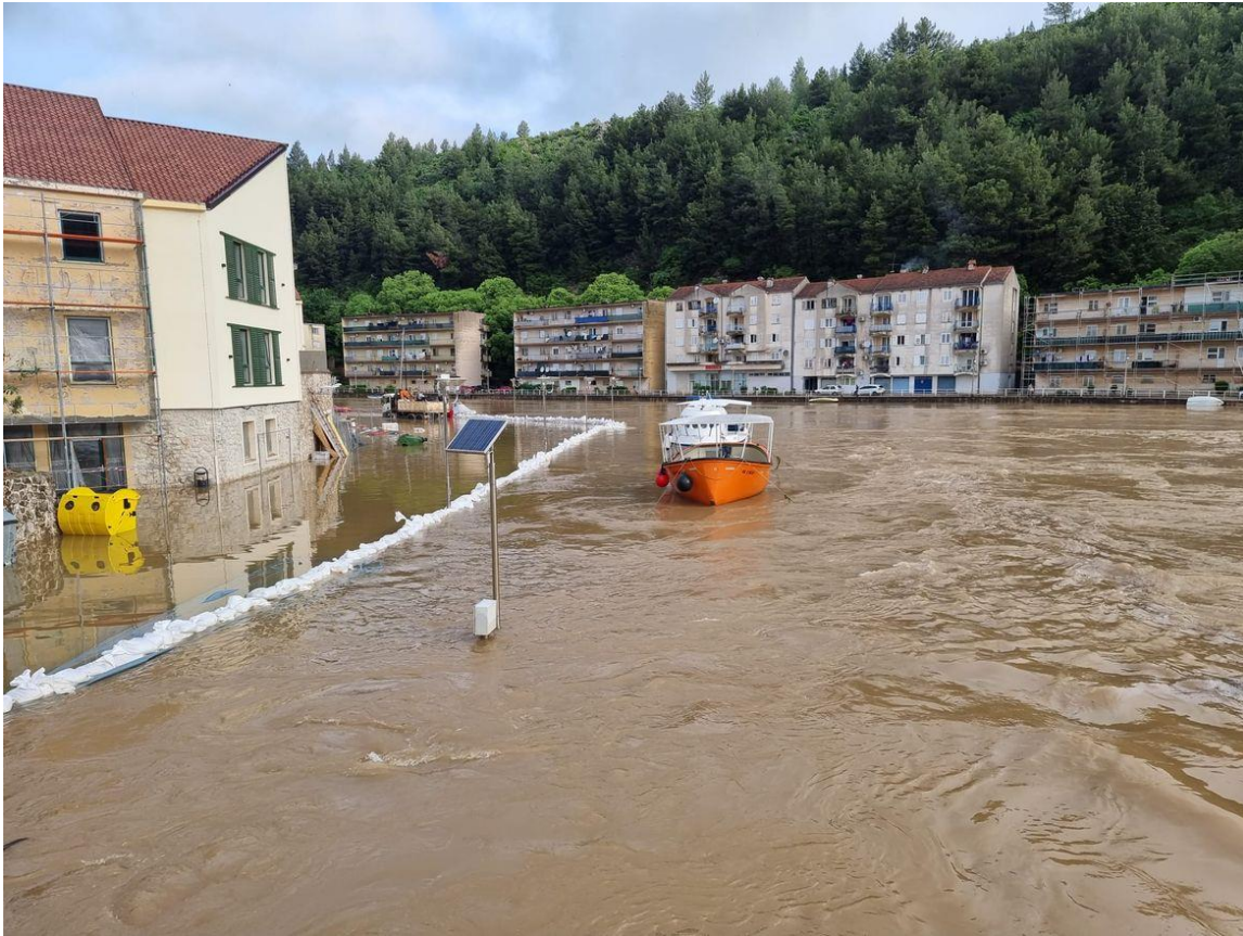
sl. 2.2.9: Lijeva obala neposredno nizvodno mosta u Obrovcu, 15.5.2023. (izvor: Portal morski.hr - https://www.morski.hr/foto-pogledajte-snimke-iz-obrovca-gdje-je-proglaseno-izvanredno-stanje/ )
