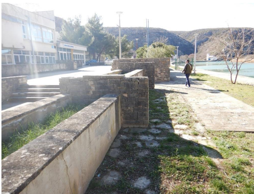
sl. 1.4.9: Pogled na sustav izgrađenih zidova nakraju predmetne dionice
