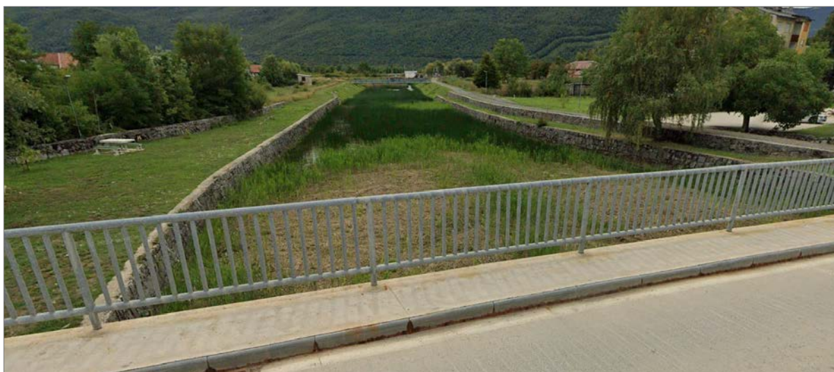
Slika 5. Pogled s mosta prema nizvodnom dijelu korita rijeke Otuče s postojećom infrastrukturom za obranu od poplava
