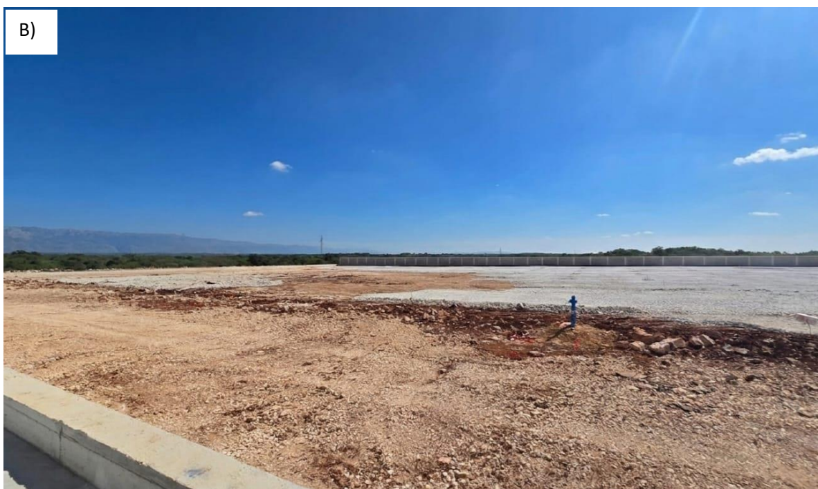
Slika 2. Fotodokumentacija lokacije zahvata A) pogled prema jugoistoku i B) pogled prema sjeveroistoku
