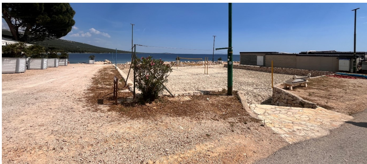
Slika 6.1. Područje radova izgradnje UPOV-a Kampa Šimuni, postojeće odbojkaško igralište (lipanj 2026.)
